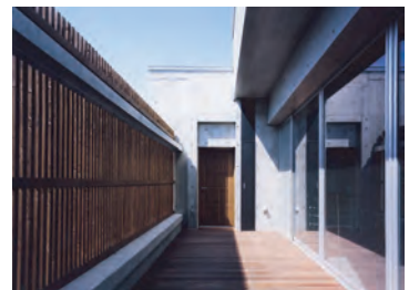
5階住宅部分 ベランダ
