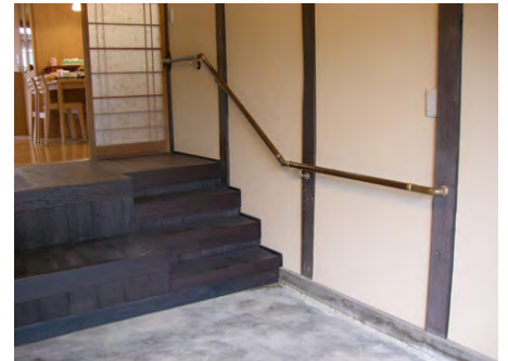
土間との段差を階段状に工夫
