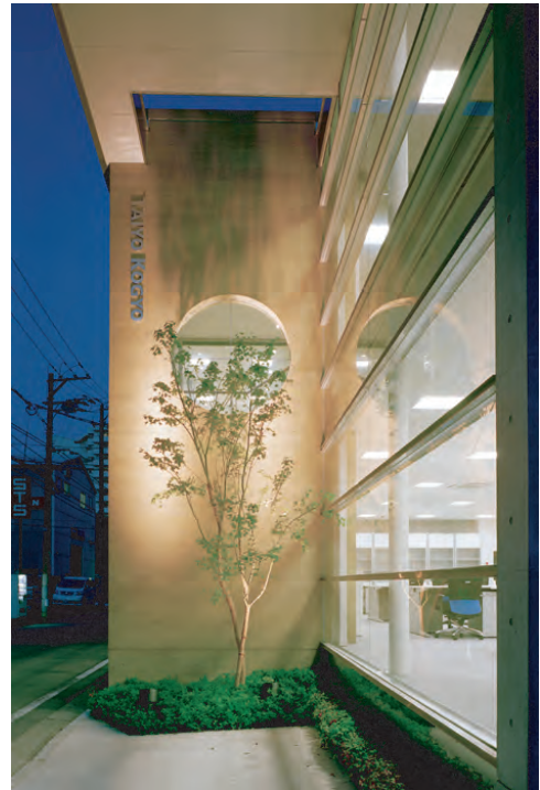
杉板型枠材を使ったコンクリート打放し
