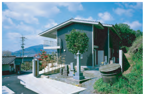
南側道路より敷地を見る
