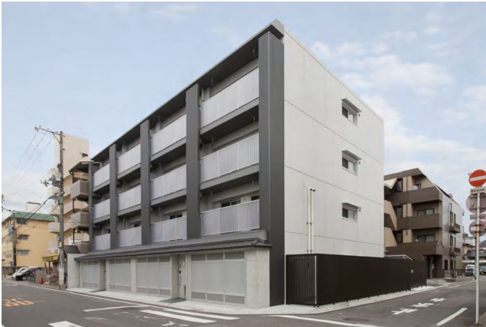
北西面外観、1階はガレージハウス
